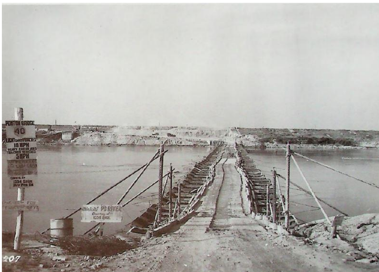
Immagine 30 – ponte militare americano flottante costruito a San Benedetto sul Po nell'aprile del 1945
